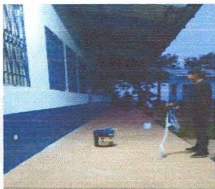
Foto 3: Mejormiento de pintura interior y exterior modulo 1 y 2
