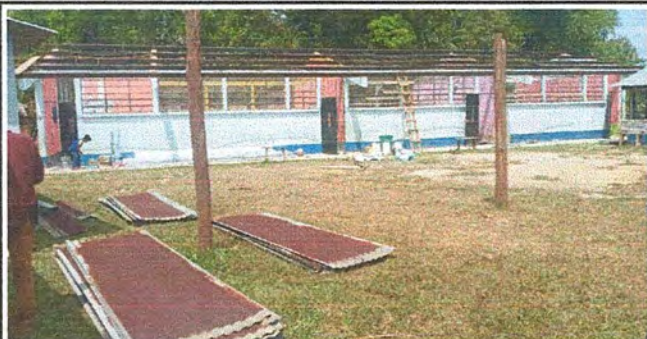
Foto 1: Cambio de lamina troquelada calibre 26 Modulo 1
