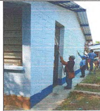
Foto 4: Pintura exterior modulo 1 y 2
