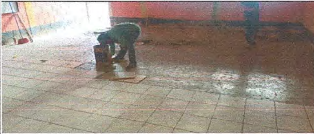
Foto 1: Colocacion de piso ceramico antideslizante Modulo 1
