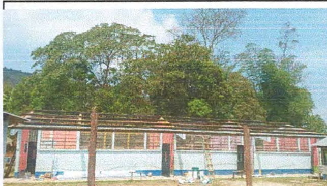
Foto 2: Cambio de estructura metalica Modulo 1
